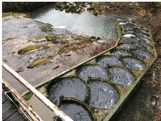
Abbildung 11: Rundbeckenfischpass am Wehr der Anlage «Les Forges» bei Undervelier (Foto: IUB)
