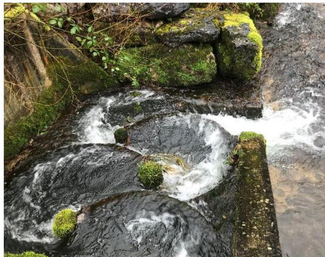
Abbildung 10: Einstieg in den RBP an der Anlage «Moulin des Roches» bei Courrendlin; welcher anders umgesetzt wurde als geplant (siehe Datenblatt in Beilage C) (Quelle: Fischwerk)
