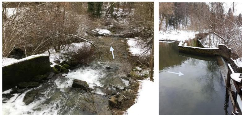
Abbildung 4: Links: Tosbecken und Unterwasser des Wehres am KW Lutz (Blick in Fließrichtung) mit linksseitiger Mittelinsel; rechts: Staubereich des KW Lutz, fotografiert von der seitlichen Fassung aus, die Mauer im Hintergrund müsste für den Bau einer FAH vermutlich durchdrungen werden (Quelle: IUB/Fischwerk)
