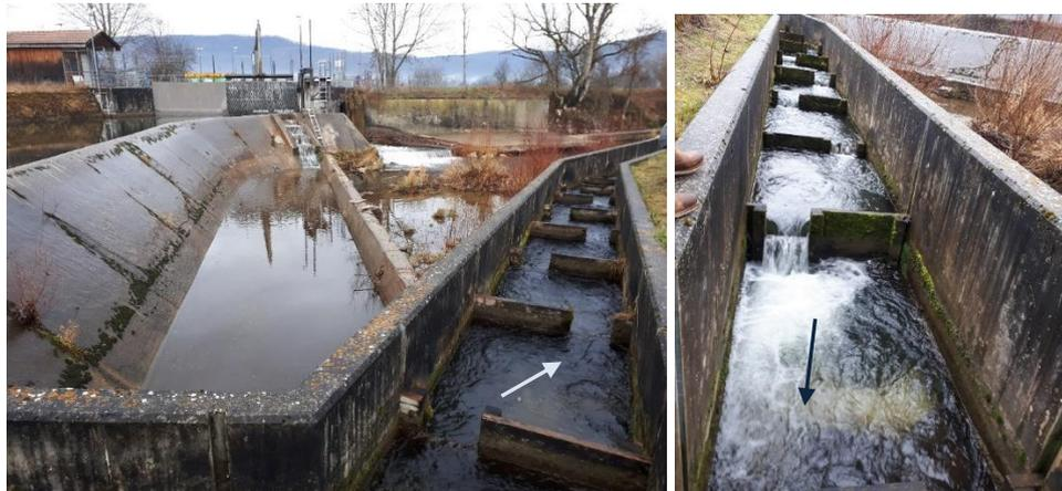
Abbildung 6: Bestehender konventioneller Beckenpass am KW Dynamo, links: Blick in Fließrichtung, rechts: Blick vom Einstieg gegen die Fließrichtung (Quelle: IUB/Fischwerk)
