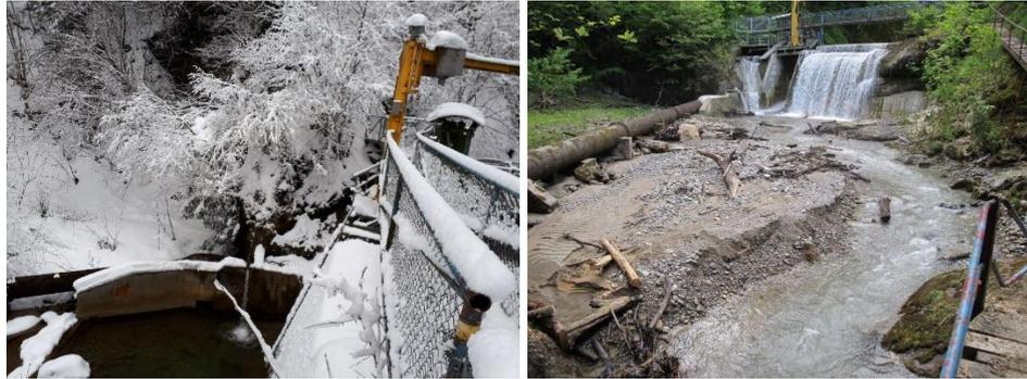
Abbildung 5: Links: Orographisch rechtes Ufer, wo die Umsetzung eines RBP mit Einstieg im Tosbecken denkbar wäre; rechts: Wehrüberfall bei Hochwasser und hohem Geschiebetrieb (Quelle: IUB/eps Power)
