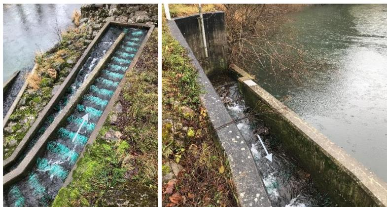
Abbildung 7: Borstenfischpass am KW Bellerive, links: Einstieg und Wendung, rechts: Ausstieg mit Blick gegen die Fließrichtung (Quelle: IUB)
