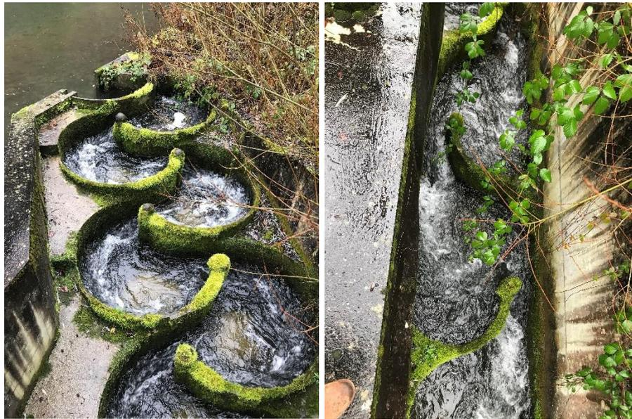
Abbildung 9: Links: Ausstieg aus dem Rundbeckenfischpass an der Anlage «Moulin des Roches» bei Courrendlin. Der Moosbewuchs wird ca. zwei Mal im Jahr bei kleineren Hochwasserereignissen weggespült. Rechts: J-Typ in der Engstelle (Fotos: IUB/Fischwerk)
